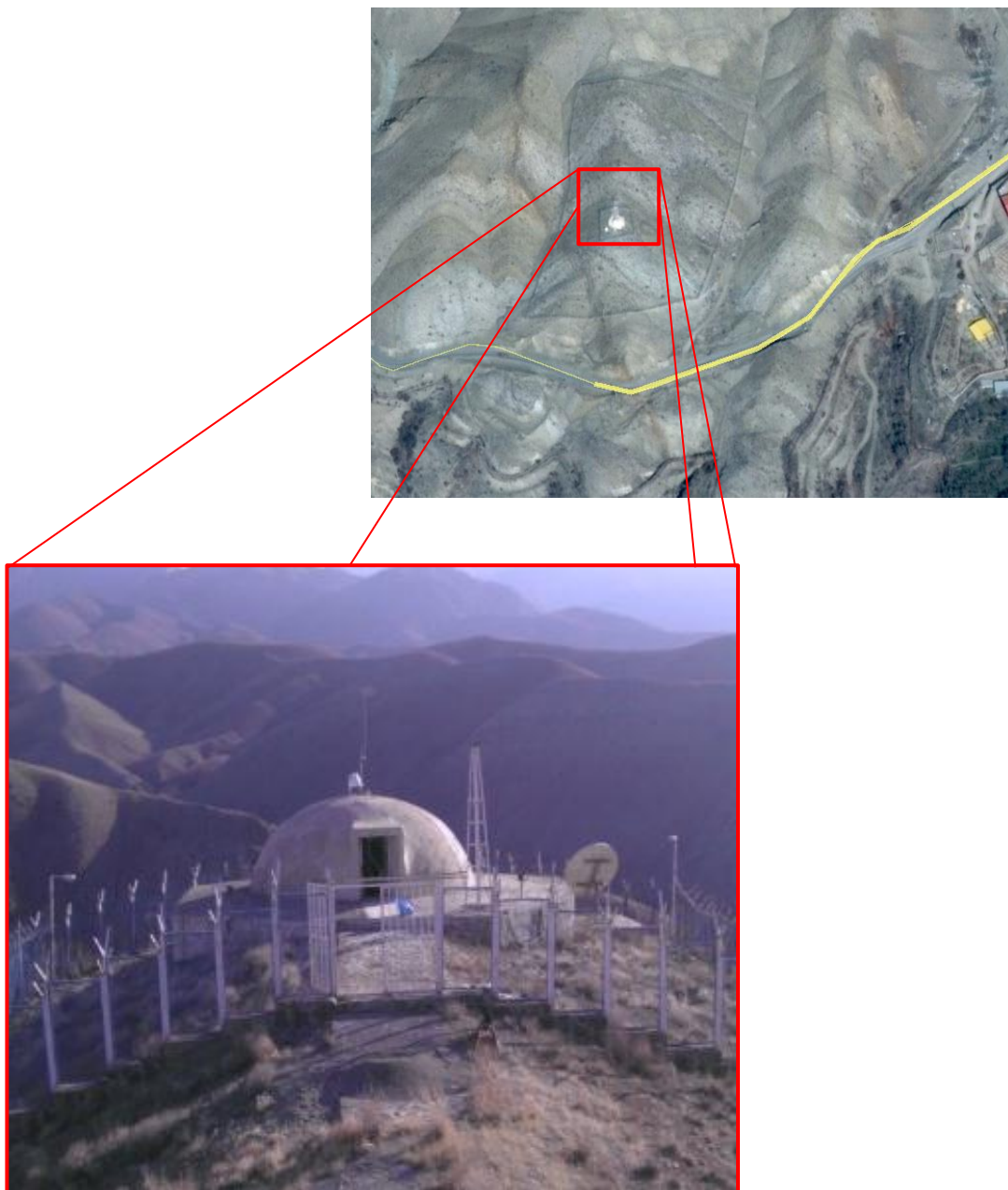
شکل ۷-۱: ایستگاه لرزه‌نگاری دماوند پژوهشگاه بین‌المللی زلزله
